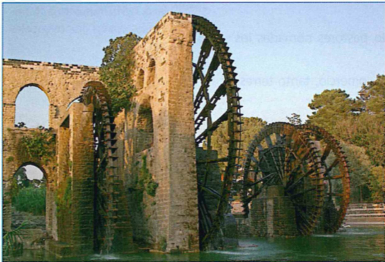
Norias de Bechriyyat, Siria. El hecho de proceder de medios geográficos desérticos, donde el aprovechamiento de los pozos era vital, hizo que los ingenieros musulmanes desarrollaran todo tipo de inventos y sistemas de ingeniería hidráulica para aplicarlos a la agricultura.
